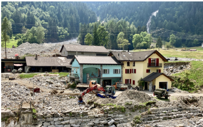
Travaux au éboulement du Piano di Peccia
