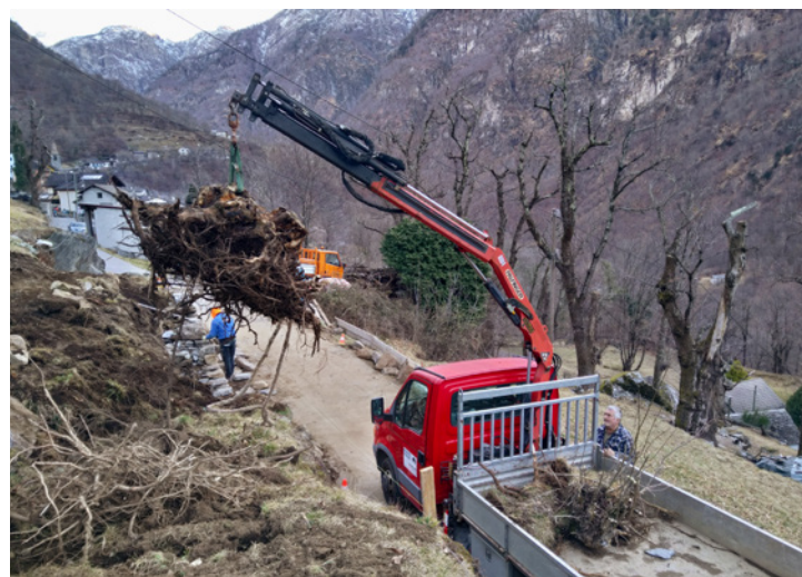
Travaux au murs à sec
