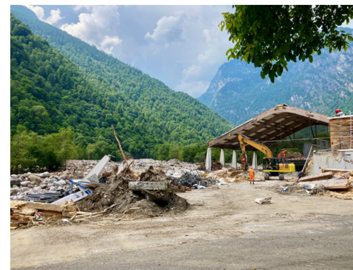
Mise en sécurité du Centre Sportive
