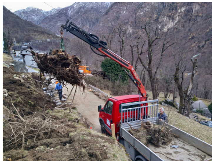
Lavori ai muri a secco
