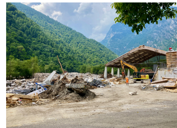
Messa in sicurezza del Centro Sportivo
