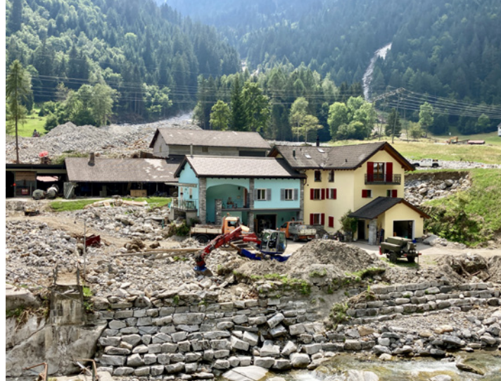
Lavori alla frana del Piano di Peccia
