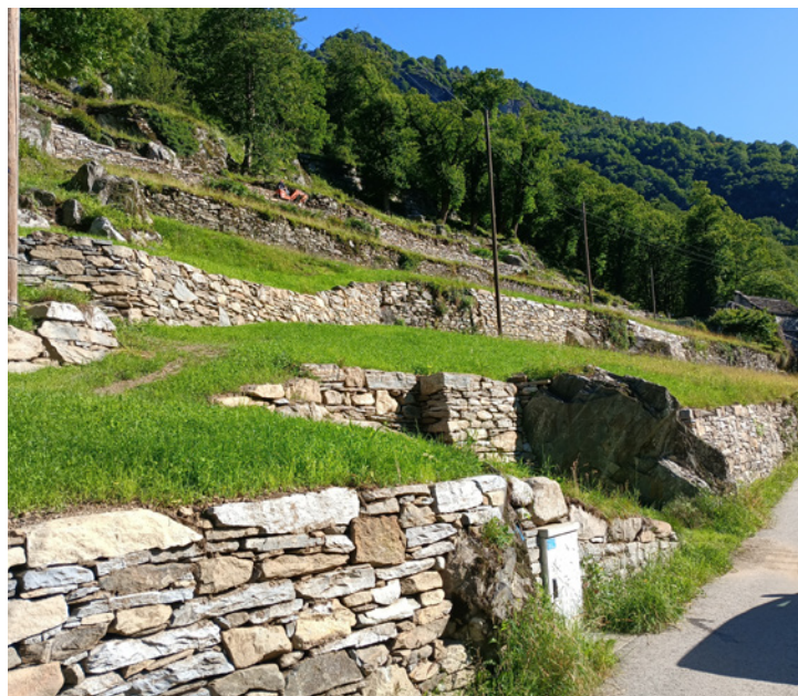
Terrazzamenti rimessi a nuovo
