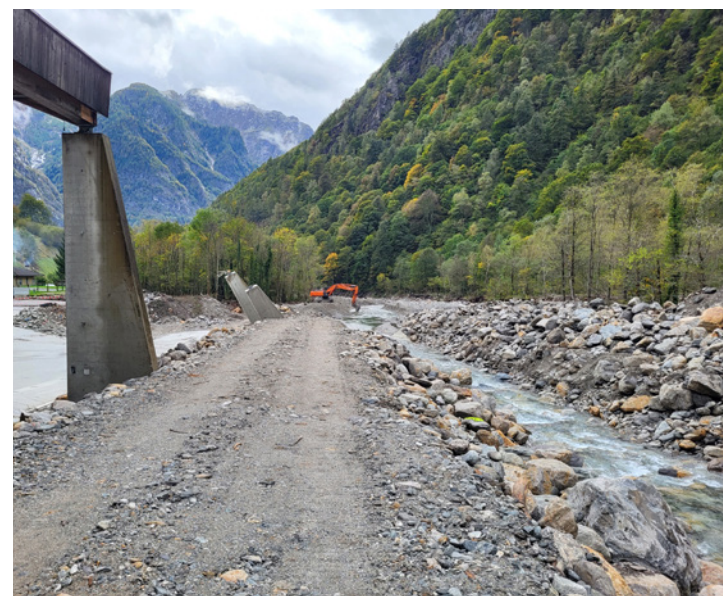
Das Flussbeet muss instandgesetzt werden
