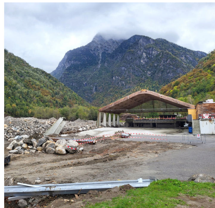
Die Eishalle wurde fast komplett zerstört
