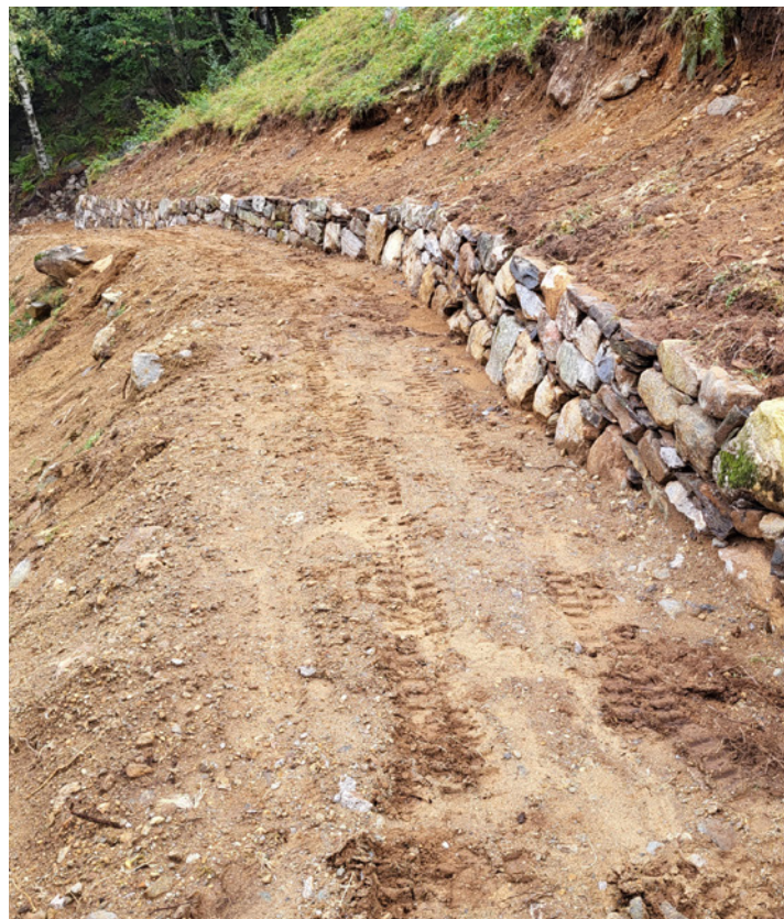
Aufbau von Trockenmauern
