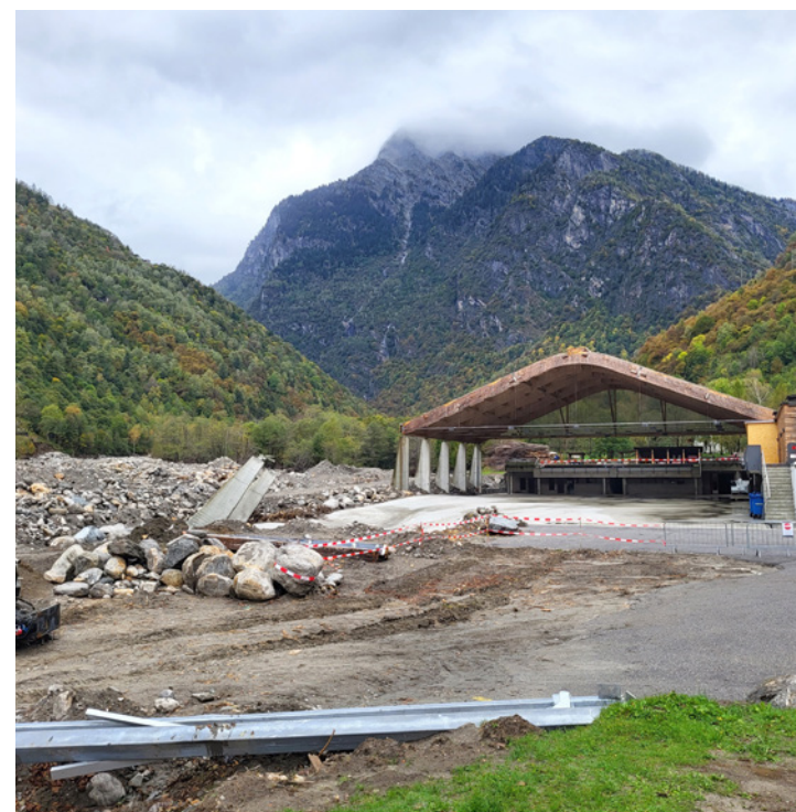
Il Centro Sportivo Lavizzara è stato quasi completamente distrutto
