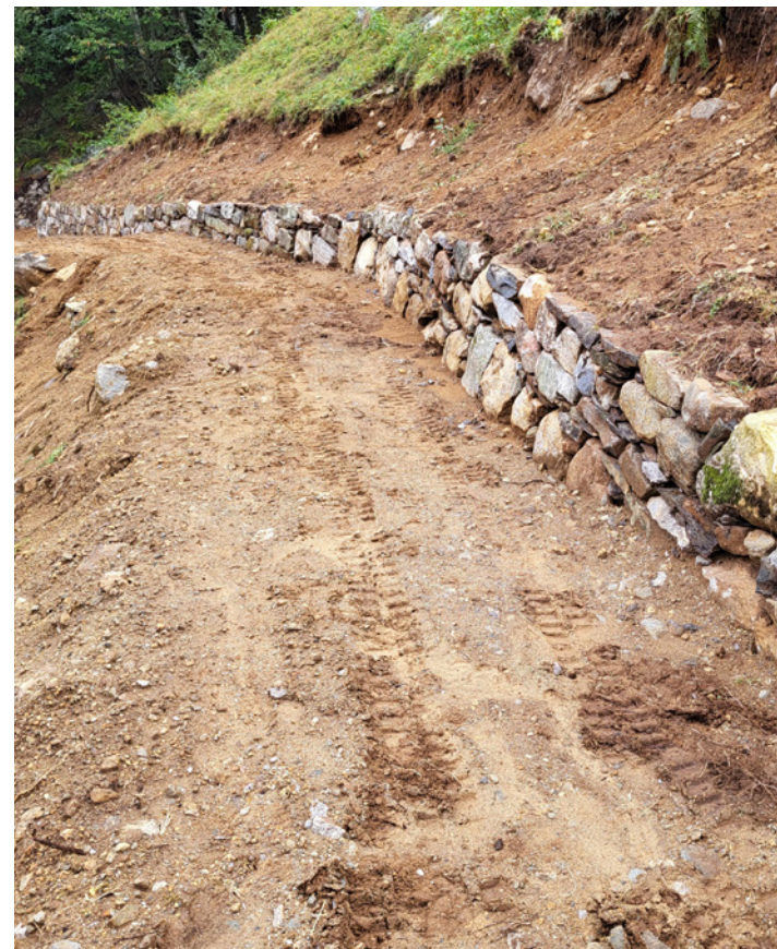
Costruzione di muri a secco
